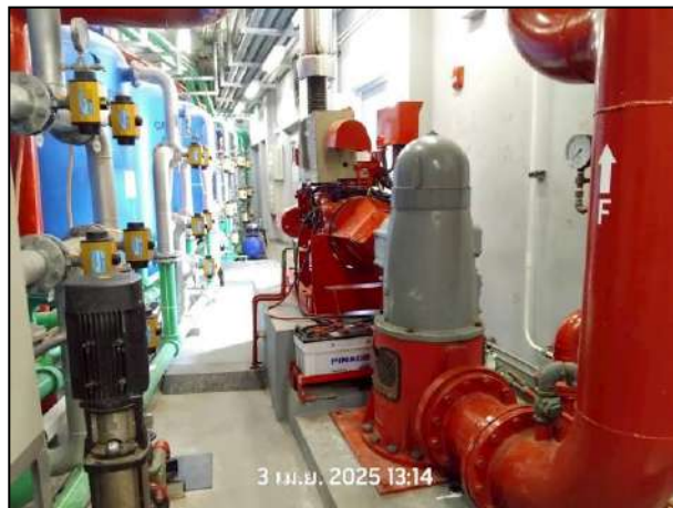
รูปที่ 2.41 ระบบ Fire Pump
