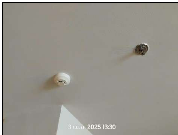
รูปที่ 2.27 อุปกรณ์ตรวจจับควัน และสปริงเกอร์ดับเพลิง
