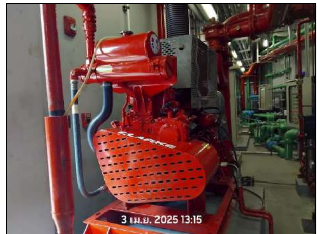
รูปที่ 2.41 ระบบ Fire Pump
